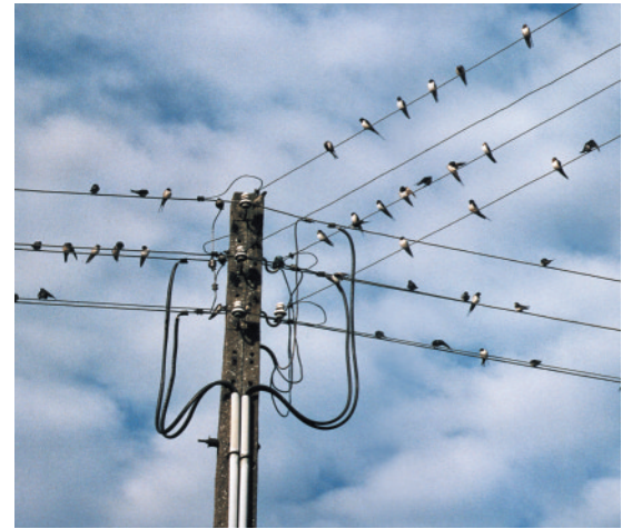
„Jaka to melodia” — Sławomir Nowak — Nagroda Zakładu Energetycznego Koszalin S.A.
